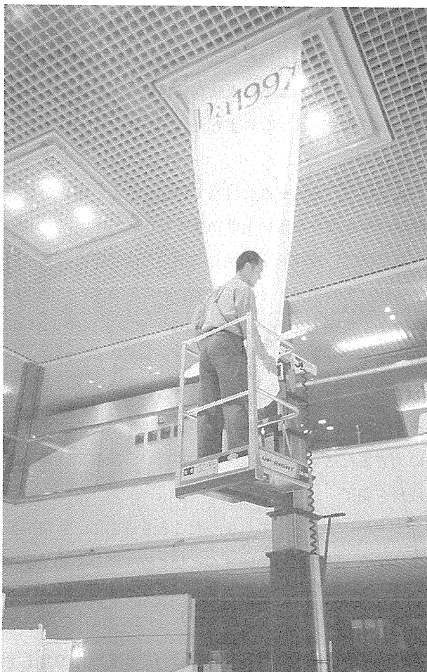
「高所作業車」を使用、吹抜けの空間に懸垂幕をつり下げ ているところ（OZONE の塚本さんの協力を得ました）
