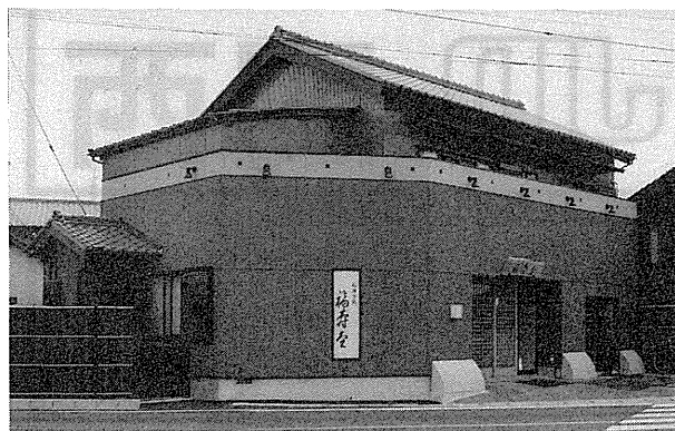
和菓子店「福寿堂」の外観、杉板の外装材に植物油系のオスモカラーを塗装した。
